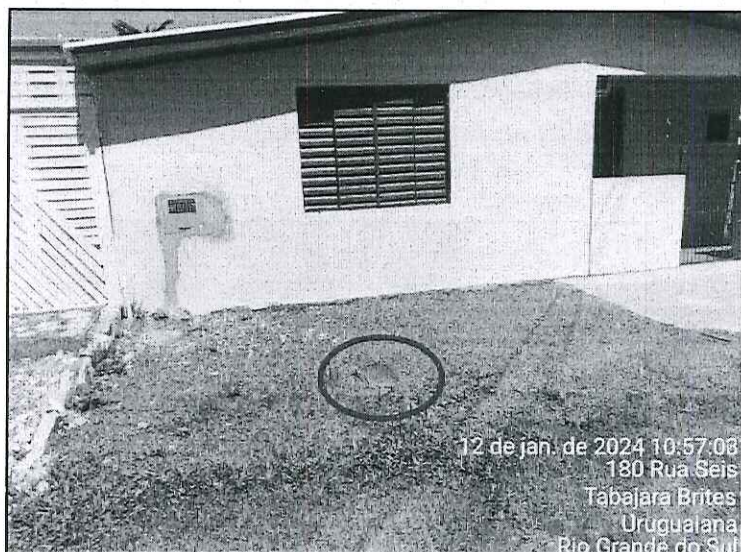
Figura 3- Fachada da residência e local do novo hidrômetro, demonstrando que não houve avarias por parte da Concessionária.
