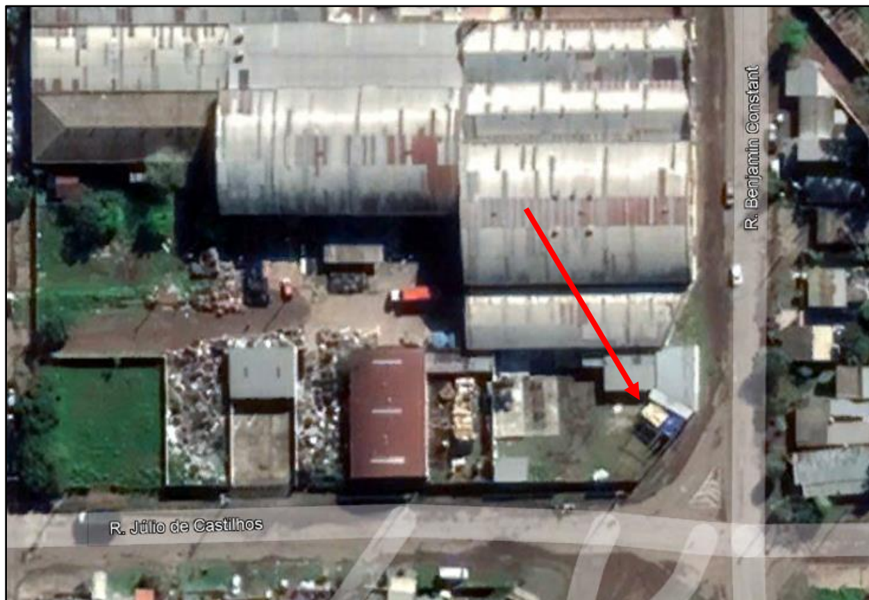
Figura 6- Indicação das infraestruturas da Escola de Samba anteriormente as referidas obras pela face da Rua Benjamin Constant.
