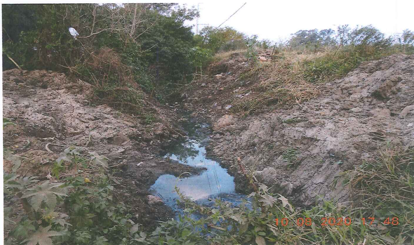
Fotos 06 a 10: Demonstram o valo construído para que a água excedente possa se conectar a água da galeria que passa sob a BR-472.
