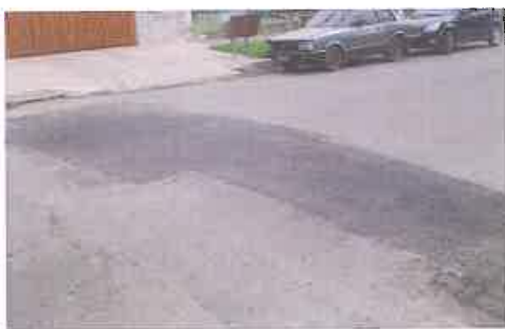
Recuperação de pavimentação de ramal de esgoto na Rua dos Andradas entre R. João Manoel e R. Vasco Alves
