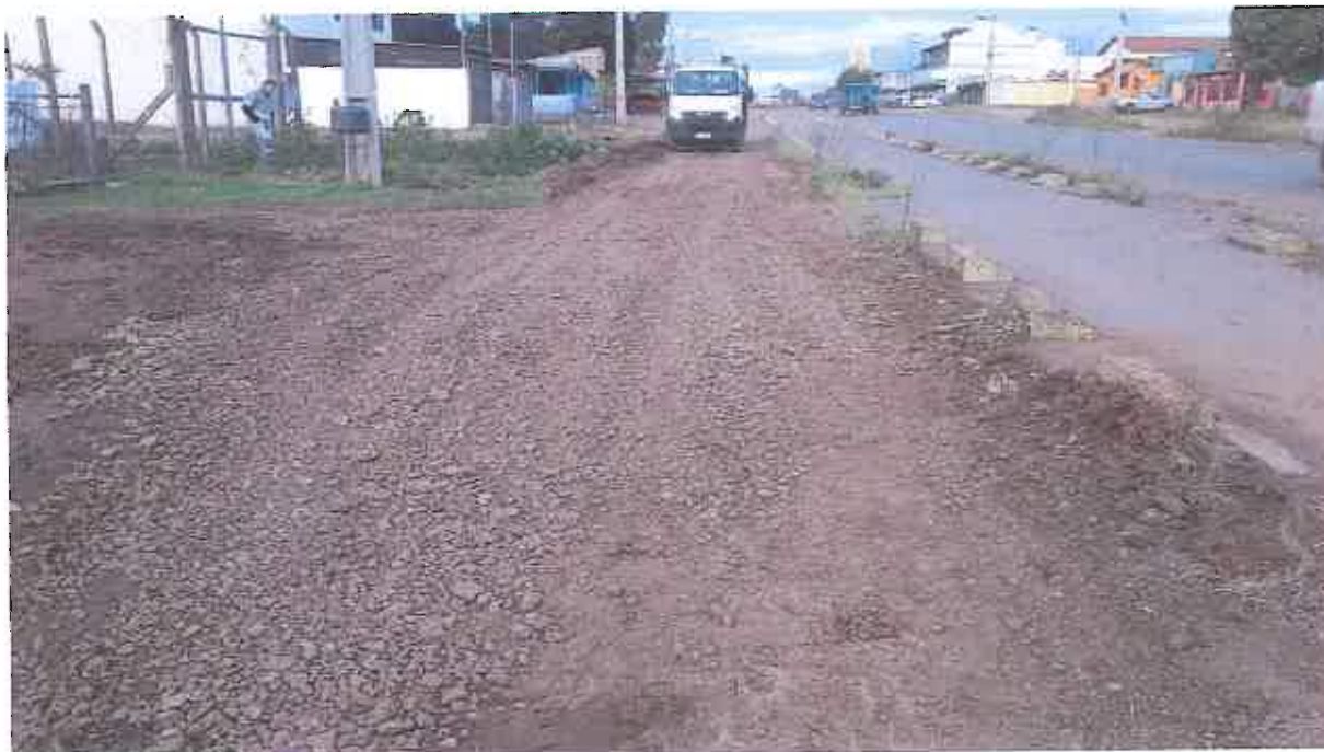
Foto 3 - Vazamento Consertado - OS 456724
