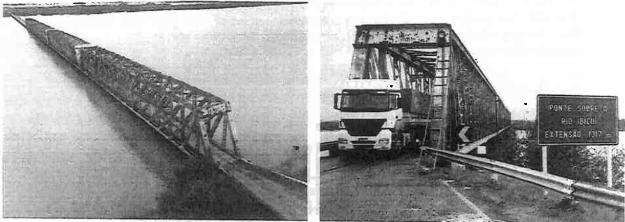
Figura 1 – Fotos da ponte existente
