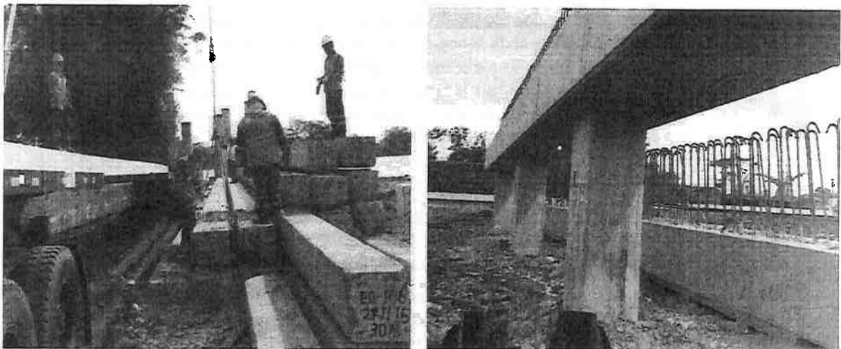
Figura 9 – Fotos das estacas pré-moldadas da ponte sobre o Rio Guaíba de dimensão da seção transversal similar às estacas de D = 0,41 m do anteprojeto
