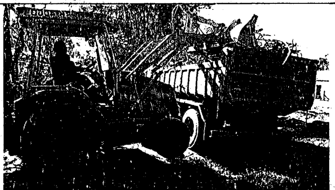
- UR 415 - BRETE DA VILA DA CHÁCARA, FOI REALIZADO COLOCAÇÃO DE MATERIAL, LIMPEZA DE VALAS E BOEIROS. VILA DE SÃO MARCOS FOI REALIZADO LIMPEZA DE VALAS E BOEIROS
