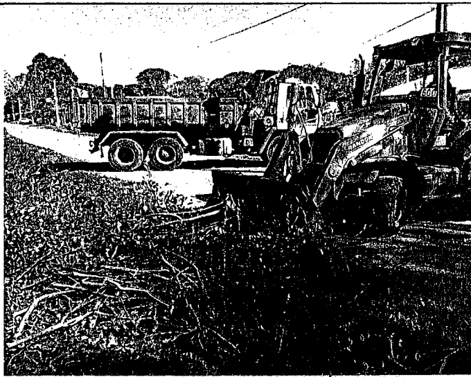
- UR 415 - BRETE DA VILA DA CHÁCARA, FOI REALIZADO COLOCAÇÃO DE MATERIAL, LIMPEZA DE VALAS E BOEIROS. VILA DE SÃO MARCOS FOI REALIZADO LIMPEZA DE VALAS E BOEIROS
