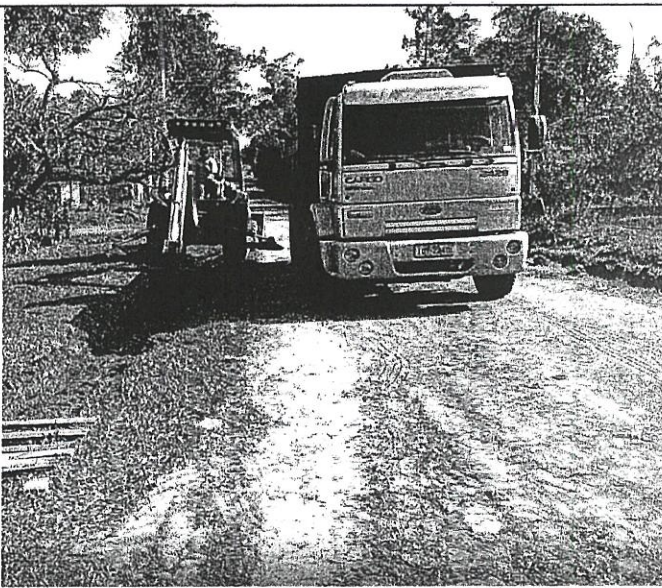
- VILA DE SÃO MARCOS, FOI REALIZADO, LIMPEZA DE VALAS E COLOCAÇÃO DE BOEIROS
