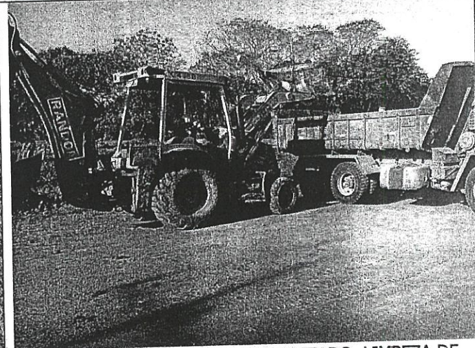
- VILA DE SÃO MARCOS, FOI REALIZADO, LIMPEZA DE VALAS E COLOCAÇÃO DE BOEIROS
