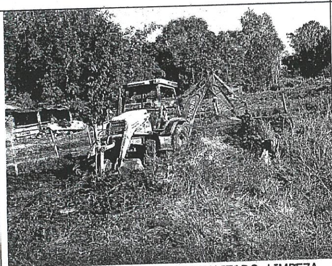
- VILA DE SÃO MARCOS, FOI REALIZADO, LIMPEZA DE VALAS E COLOCAÇÃO DE BOEIROS.
