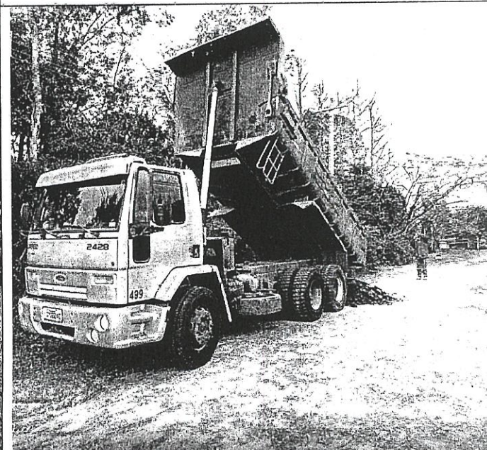
BARRAGEM SANCHURI, FOI REALIZADO COLOCAÇÃO DE MATERIAL E LIMPEZA DE VALAS.
