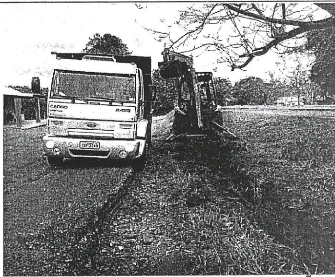
BARRAGEM SANCHURI, FOI REALIZADO COLOCAÇÃO DE MATERIAL E LIMPEZA DE VALAS.
