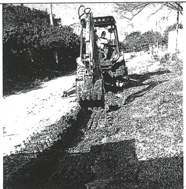
- VILA DE SÃO MARCOS, FOI REALIZADO, LIMPEZA DE VALAS E COLOCAÇÃO DE BOEIROS.
