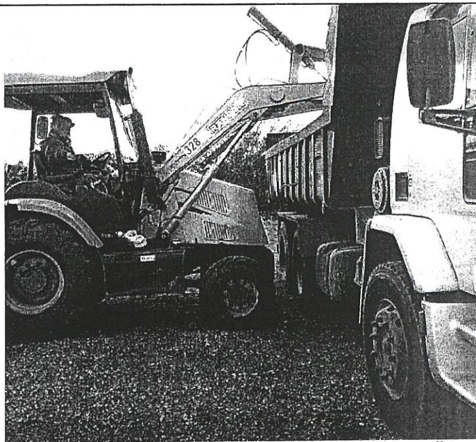
BARRAGEM SANCHURI, FOI REALIZADO COLOCAÇÃO DE MATERIAL E LIMPEZA DE VALAS.
