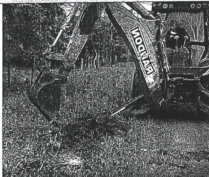
BARRAGEM SANCHURI, FOI REALIZADO COLOCAÇÃO DE MATERIAL E LIMPEZA DE VALAS.
