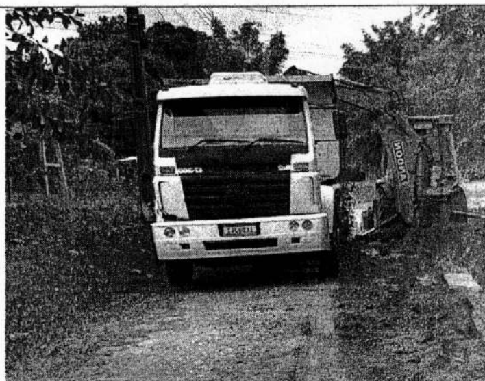
UR 415 - ADOLFO STERN, VILA DA CHÁCARA COLOCAÇÃO MATERIAL E LIMPEZA DE VALAS E DRENOS
