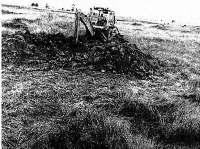
UR 415 - ADOLFO STERN, VILA DA CHÁCARA COLOCAÇÃO MATERIAL E LIMPEZA DE VALAS E DRENOS
