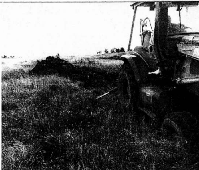
UR 415 - ADOLFO STERN, VILA DA CHÁCARA COLOCAÇÃO MATERIAL E LIMPEZA DE VALAS E DRENOS
