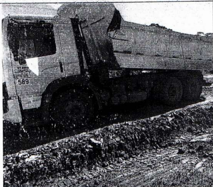
UR 415 - BRETE DO ADOLFO STERN VILA DA CHÁCARA COLOCAÇÃO DE MATERIAL E LIMPEZA DE CHARGETA
