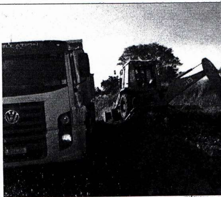
UR 415 - BRETE DO ADOLFO STERN VILA DA CHÁCARA COLOCAÇÃO DE MATERIAL E LIMPEZA DE CHARGETA
