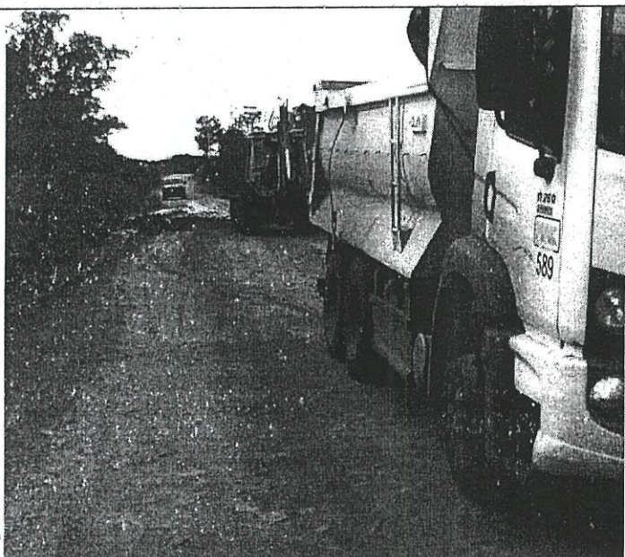
UR 201 - VILA DE JOÃO ARRREGUI, FOI REALIZADO TRAVESSIA DE BUEIROS, LIMPEZA DE VALAS E COLOCAÇÃO DE MATERIAL EM 13 QUILOMETROS
