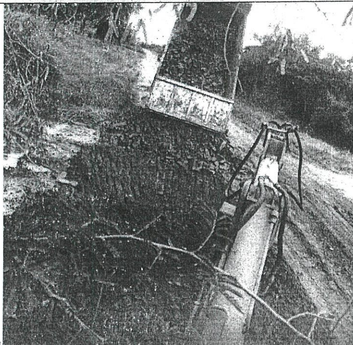
UR 201 - VILA DE JOÃO ARRREGUI, FOI REALIZADO TRAVESSIA DE BUEIROS, LIMPEZA DE VALAS E COLOCAÇÃO DE MATERIAL EM 13 QUILOMETROS
