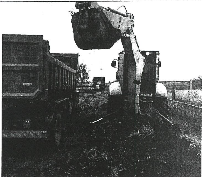
UR 201 - VILA DE JOÃO ARRREGUI, FOI REALIZADO TRAVESSIA DE BUEIROS, LIMPEZA DE VALAS E COLOCAÇÃO DE MATERIAL EM 13 QUILOMETROS
