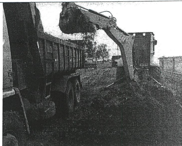
JR 201 - VILA DE JOÃO ARRREGUI, FOI REALIZADO TRAVESSIA DE BUEIROS, LIMPEZA DE VALAS E COLOCAÇÃO DE MATERIAL EM 13 QUILOMETROS
