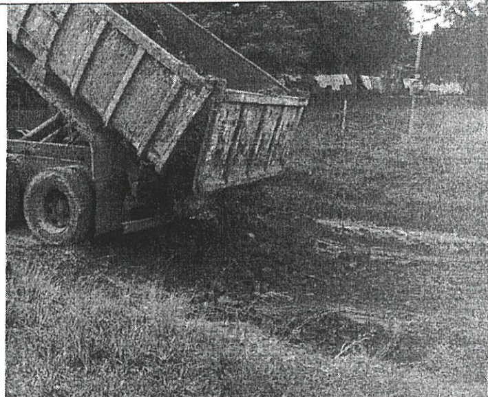
UR 201 - VILA DE JOÃO ARRREGUI, FCI REALIZADO TRAVESSIA DE BUEIROS, LIMPEZA DE VALAS E COLOCAÇÃO DE MATERIAL EM 13 QUILOMETROS
