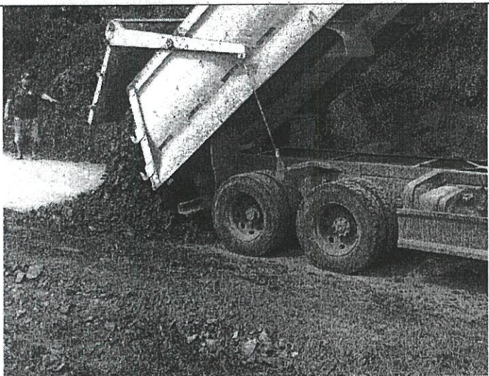
UR 201 - VILA DE JOÃO ARRREGUI, FOI REALIZADO TRAVESSIA DE BUEIROS, LIMPEZA DE VALAS E COLOCAÇÃO DE MATERIAL EM 13 QUILOMETROS
