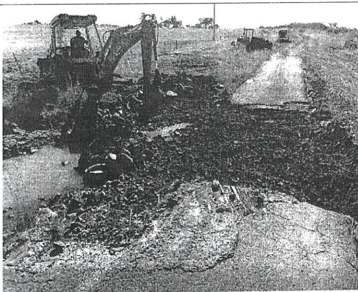
UR 204 - BRETE CHARQUEADA, FOI REALIZADO TRAVESSIA DE BOEIROS E CCLOCAÇÃO DE MATERIAL
