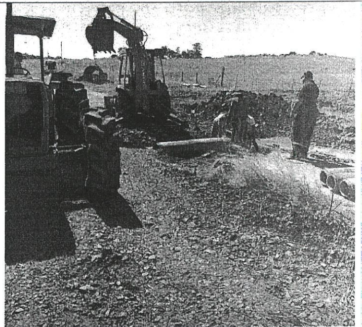
UR 204 - BRETE CHARQUEADA, FOI REALIZADO TRAVESSIA DE BOEIROS E COLCCAÇÃO DE MATERIAL
