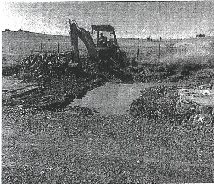
UR 204 - BRETE CHARQUEADA, FOI REALIZADO TRAVESSIA DE BOEIROS E CCLOCAÇÃO DE MATERIAL
