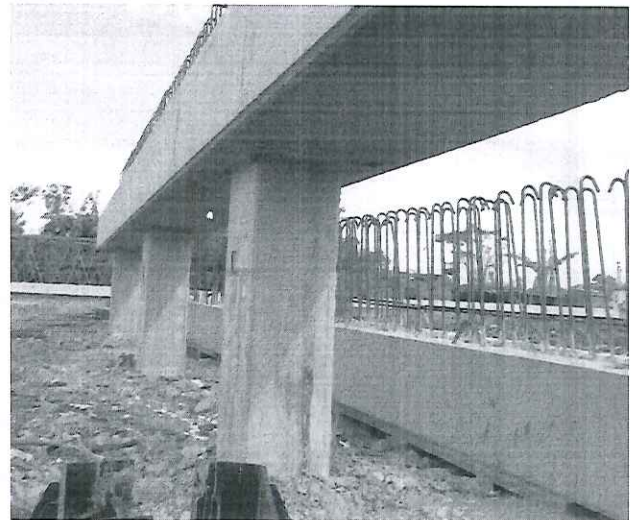
Figura 9 – Fotos das estacas pré-moldadas da ponte sobre o Rio Guaíba de dimensão da seção transversal similar às estacas de D = 0,41 m do anteprojeto
