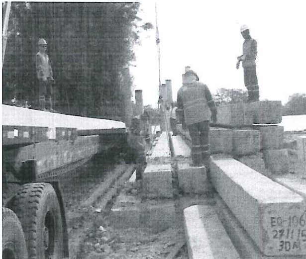
Figura 9 – Fotos das estacas pré-moldadas da ponte sobre o Rio Guaíba de dimensão da seção transversal similar às estacas de D = 0,41 m do anteprojeto
