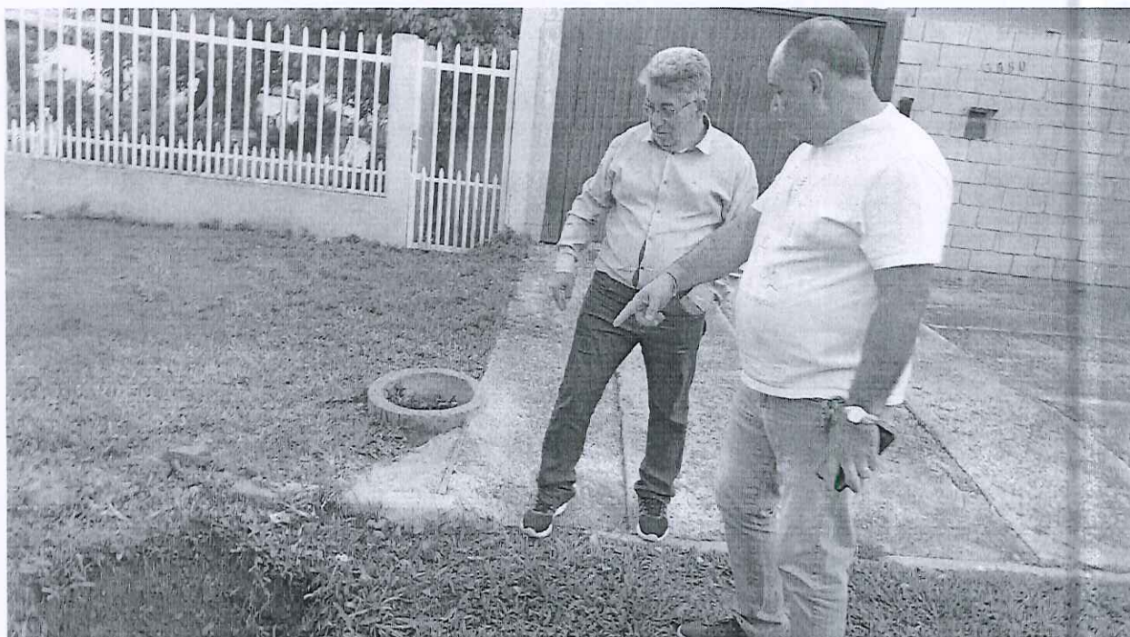
Rua Vasco Alves nº 3616, bairro Santo Antônio, em Uruguaiana Rede de Esgoto (identificação do problema)
