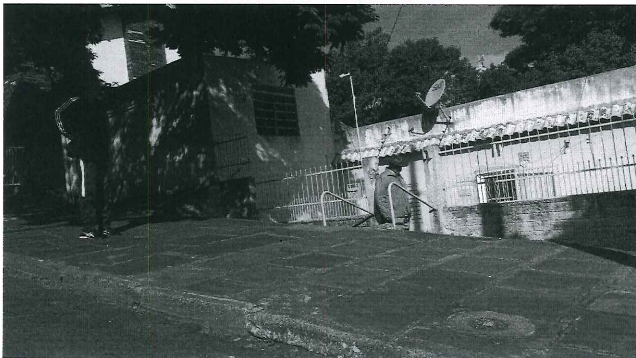
Residência muito abaixo do nível da rua
