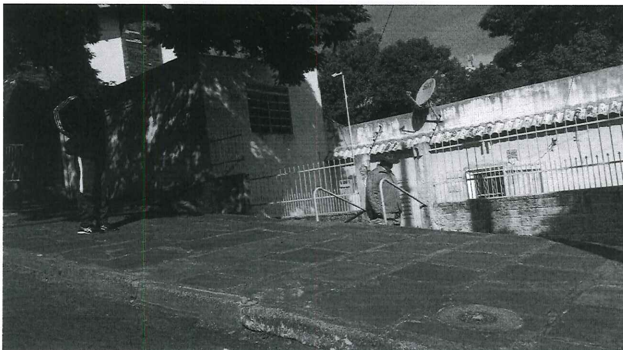
Residência muito abaixo do nível da rua
