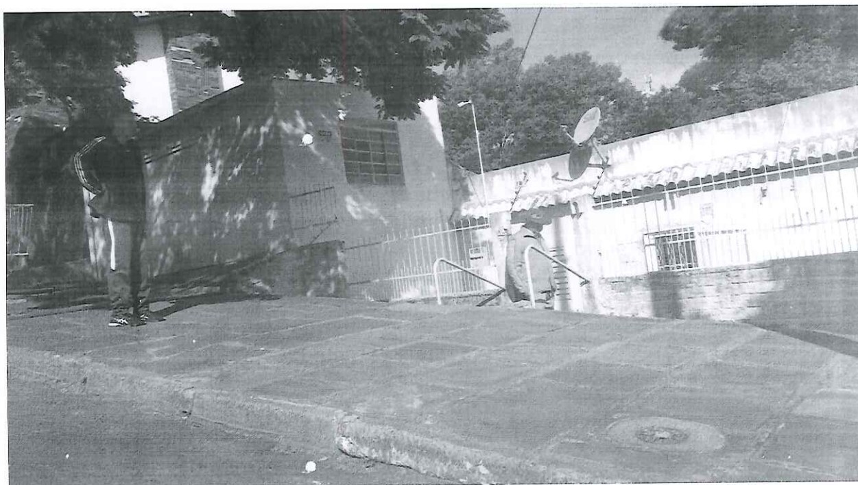
Residência muito abaixo do nível da rua
