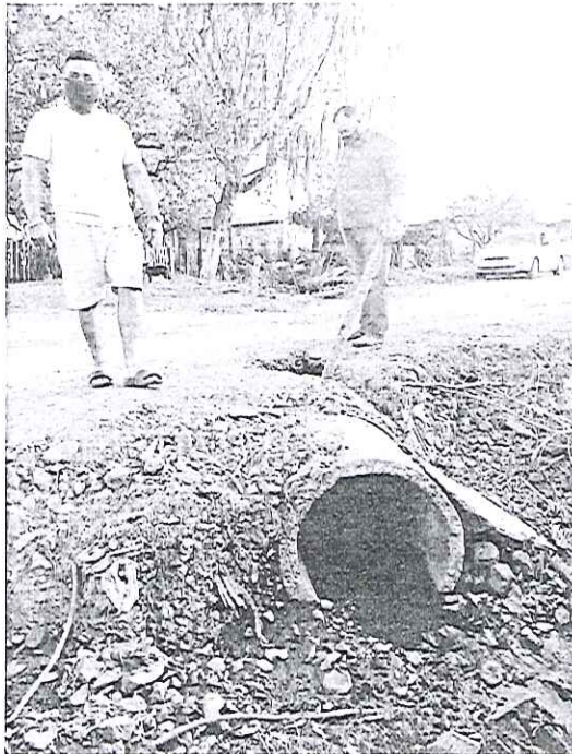
Rua Rodrigues Portugal
