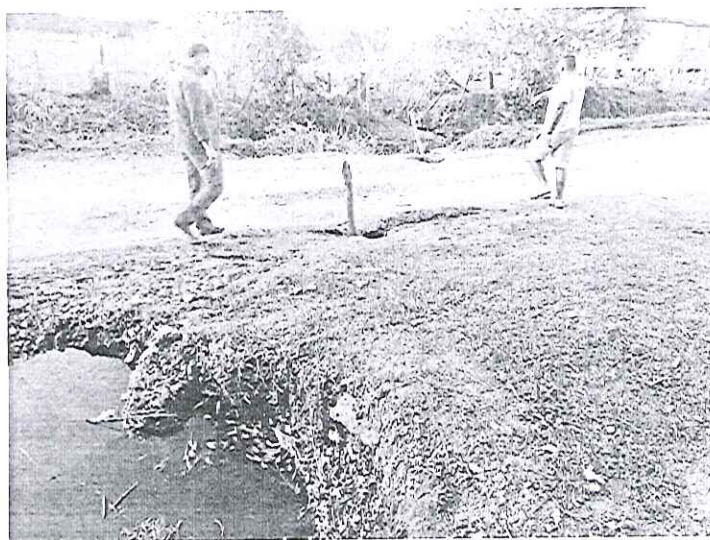
Rua Rodrigues Portugal
