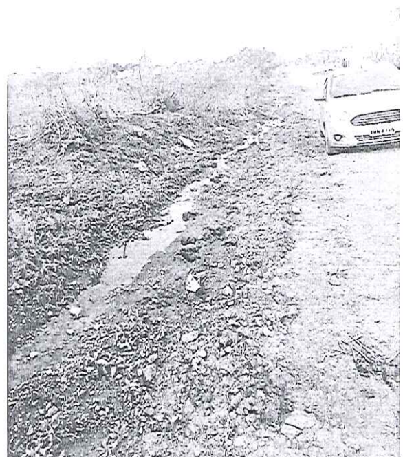
Rua Rodrigues Portugal
