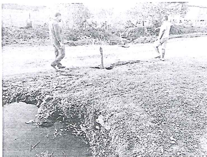
Rua Rodrigues Portugal
