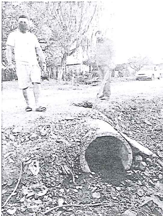
Rua Rodrigues Portugal
