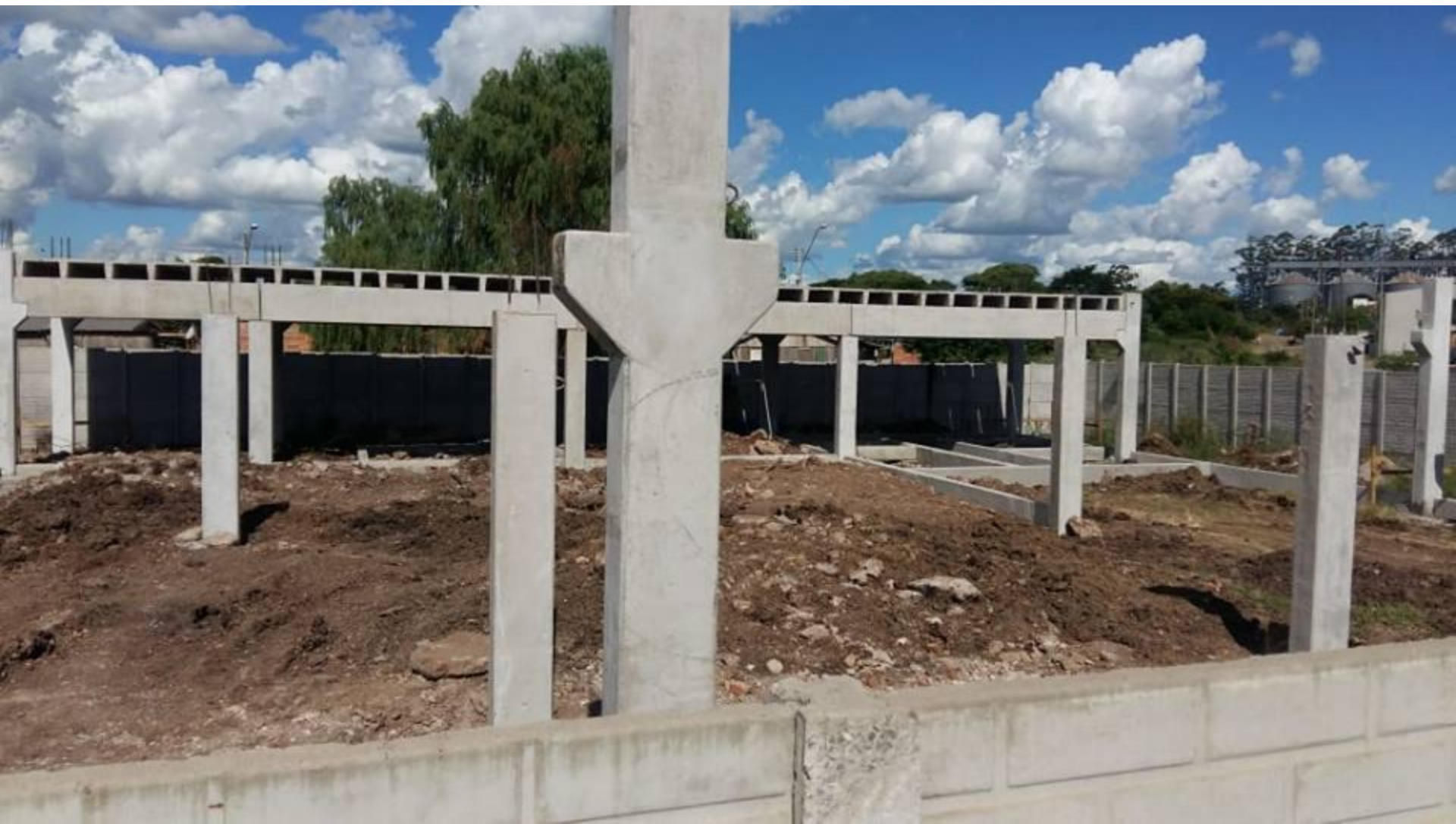
Colocação das vigas pre-moldadas;
