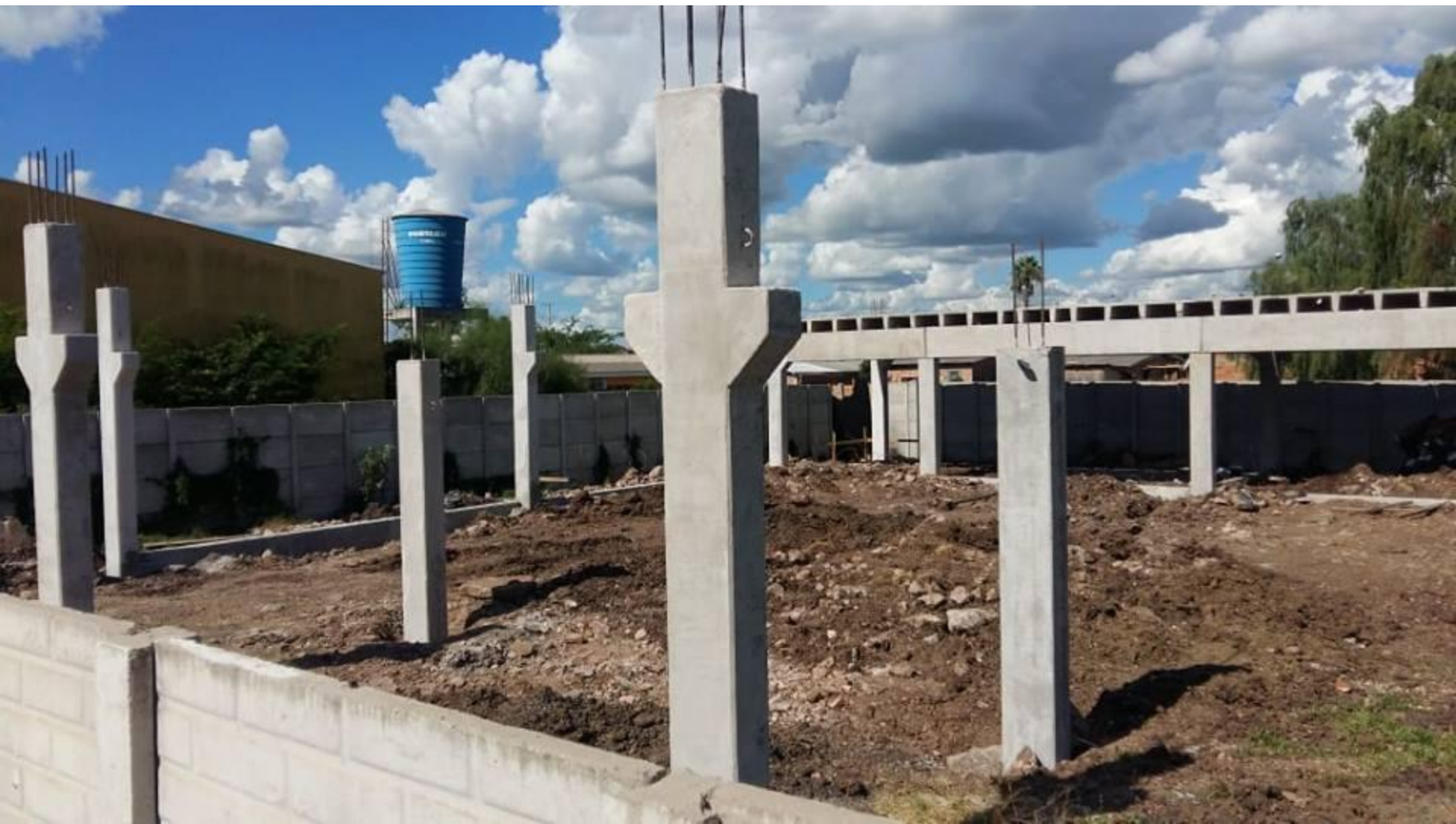
Colocação das vigas pre-moldadas;
