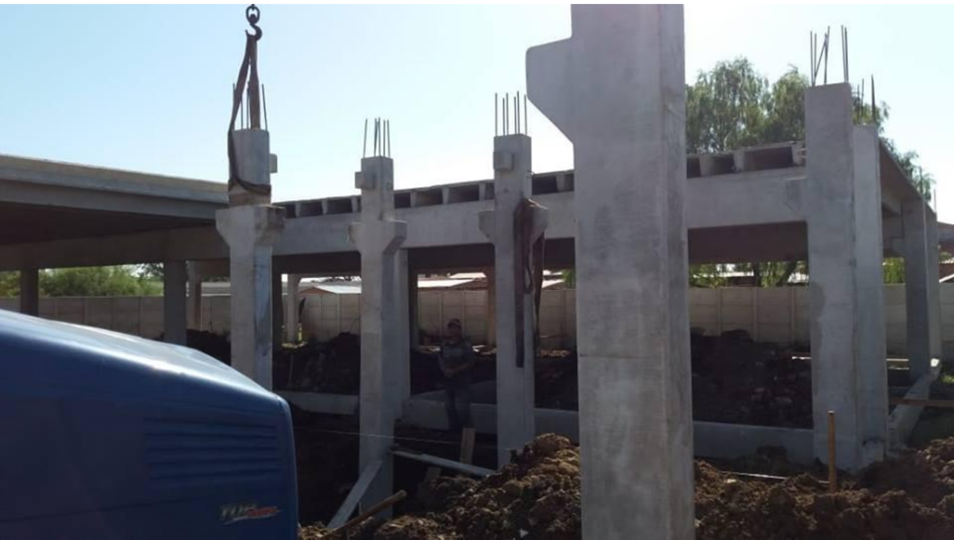
Colocação das vigas pre-moldadas;
