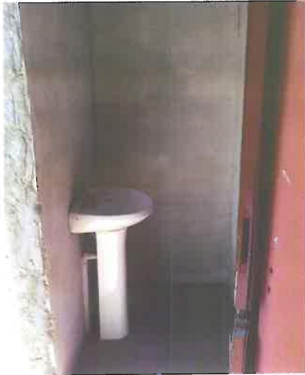
O compartimento do lavatório não possui piso cerâmico e nem azulejos nas paredes, o piso existente é de cimento alisado.
