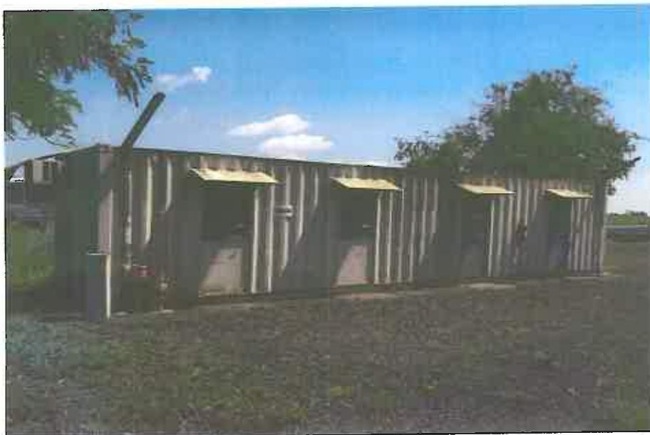
Container medindo 2,45 metros de largura por 12,20 metros de comprimento, sua estrutura metálica possui portas e janelas basculantes também metálicas.
