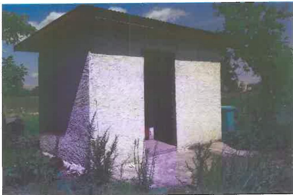
Prédio em alvenaria de tijolos tipo seis furos, revestidos com argamassa emboçada e cobertura com chapas de zinco apoiadas em estrutura de madeira.
